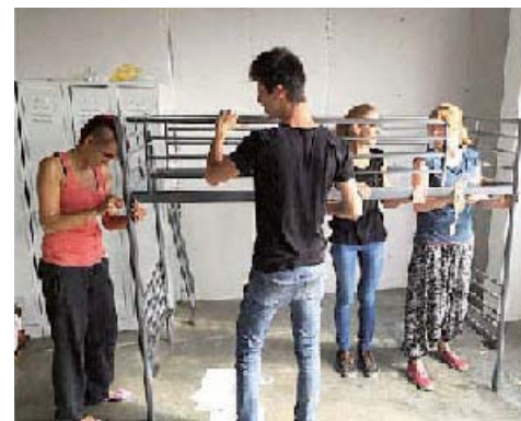
Vorbereitungsarbeiten in der Halle 18: Gerechnet haben wir mit 10 bis 15 Personen. Gekommen sind 71. Es wurden die Stahlrohrbetten zusammengeschaubt, die Räume geputzt, Tische, Spinde und Sessel aufgestellt.
